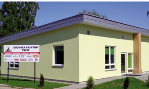
Budynek szkoleniowy - dom pasywny
