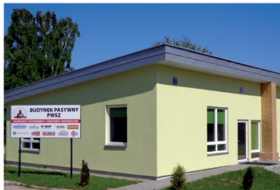
Budynek szkoleniowo-laboratoryjny – „dom pasywny” PWSZ w Kaliszu
