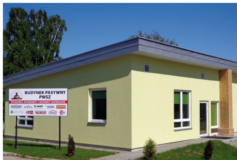
Budynek szkoleniowo-laboratoryjny – „dom pasywny” PWSZ w Kaliszu
