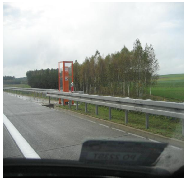
System telefonów łączności alarmowej
